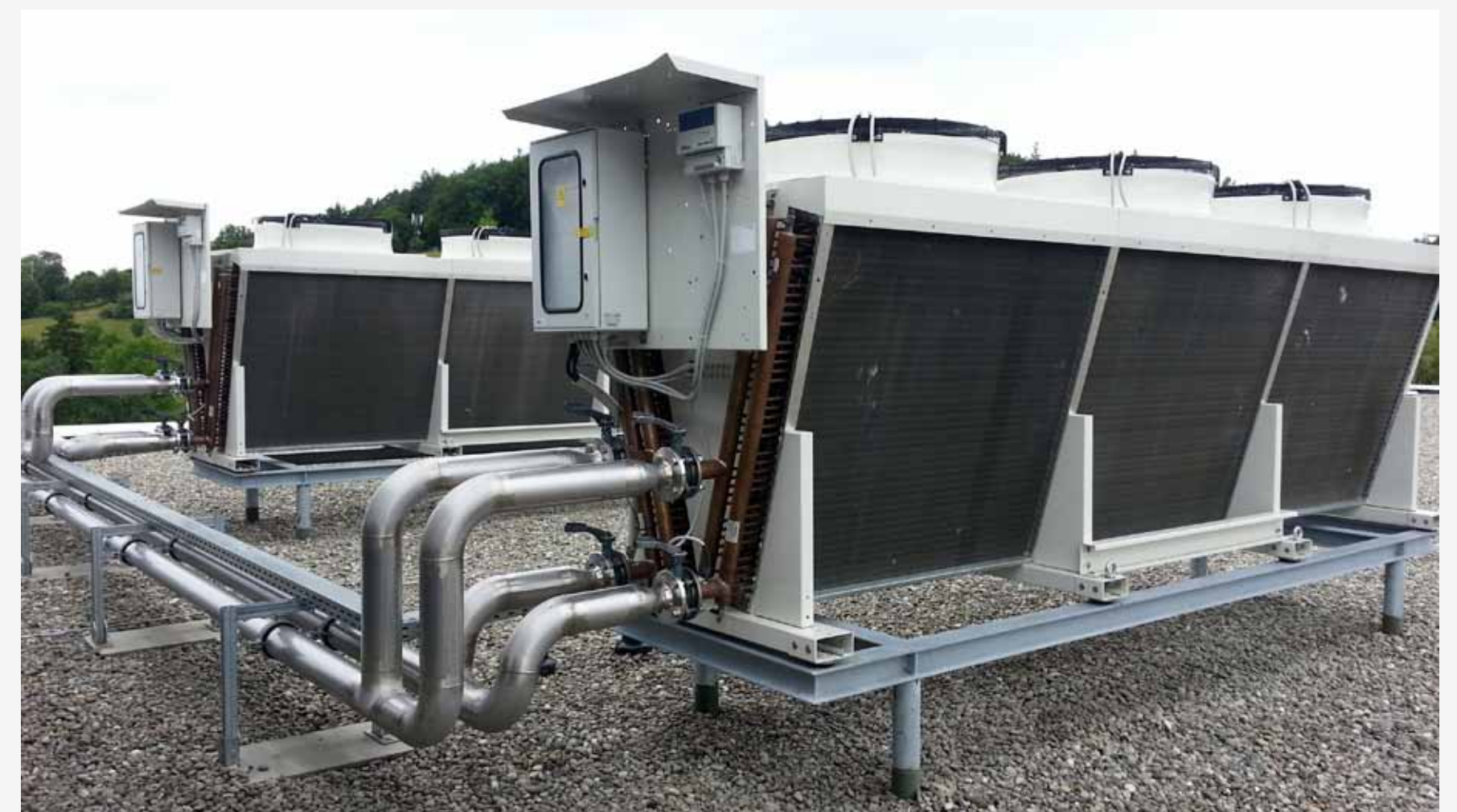
► Magnetresonanztomograph (3 Tesla) in den Kliniken Schmieder Allensbach sowie Kälteanlagen und Freikühler auf dem Dach der Klinik
